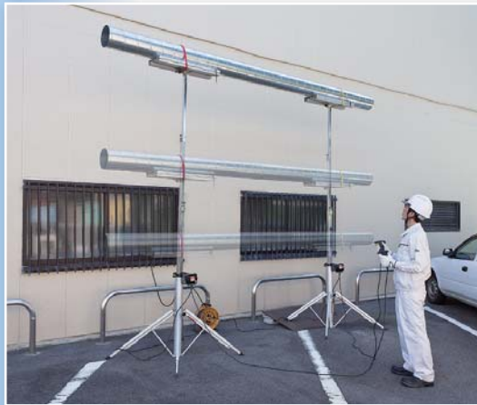
配管・空調ダクトの取付け作業
