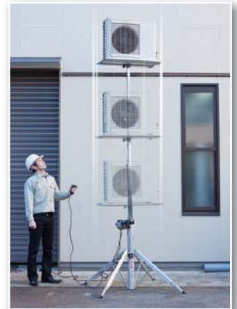
室外機揚げ作業
