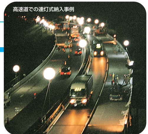
操作盤の電源を入れると空気が気球内に送風。点灯「ON」で瞬時に明るく点灯します。
